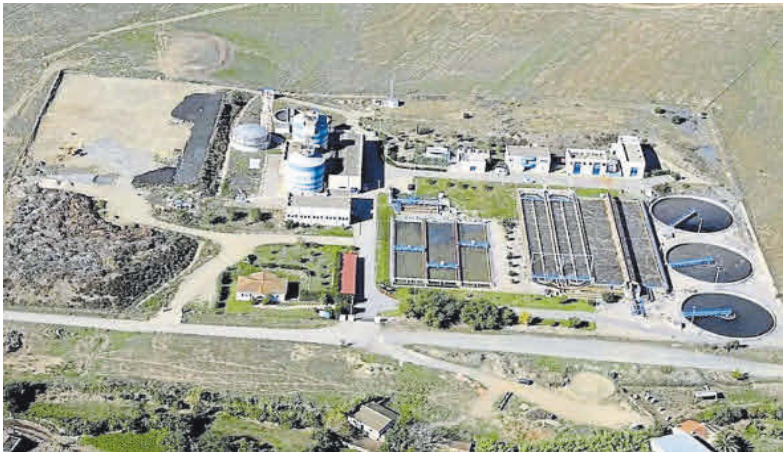
Así es la actual depuradora de la Ribera del Marco de Cáceres.
